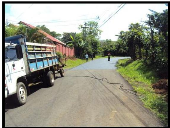
177 Alicia Vega Se conforma y coloca perfilado para realizar Tratamiento Superficial
