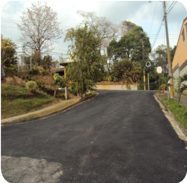
Urbanización El Jardín Bacheo menor con mezcla asfáltica Costo: ₡ 6.746.000
