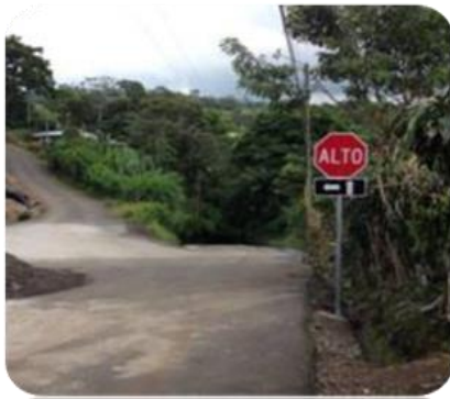
Se colocaron dos Señales de Alto y Flechas Complementarias
