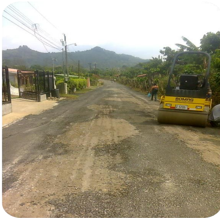
San Miguel - Calle La Herediana Tratamiento Superficial Bituminoso TSB -3 Costo: ₡1.766.887.50
