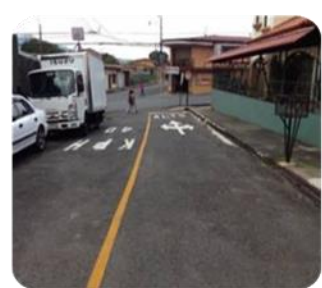
Se Coloco un letrero de alto, con línea de Paro y las flechas direccionales
