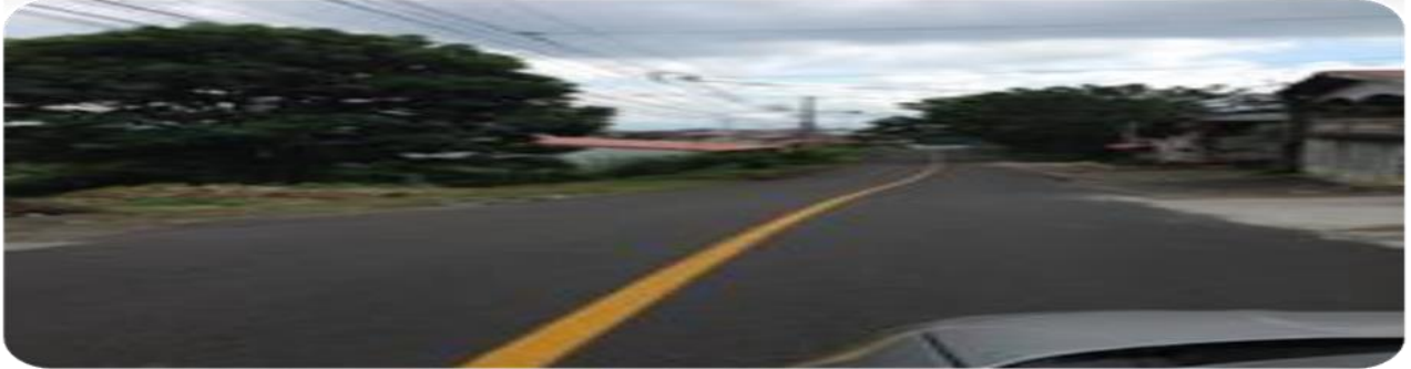
Se hizo una línea Amarilla de 300 metros de largo
