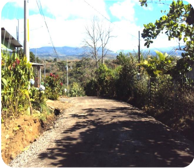
El Muro Calle Orlich – Tratamiento Superficial Bituminoso (TSB - 3) Costo: ₡ 2.951.130
