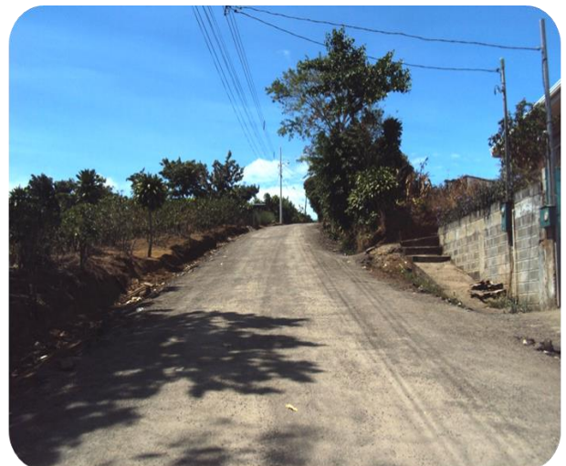
El Muro Calle Orlich –Tratamiento Superficial Bituminoso (TSB) Costo: ₡2.951.130
