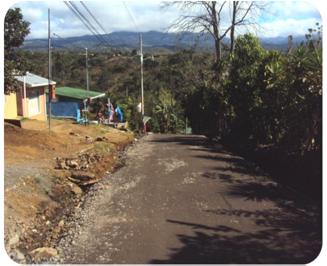
El Muro Calle Orlich – Tratamiento Superficial Bituminoso (TSB - 3) Costo: ₡ 2.951.130
