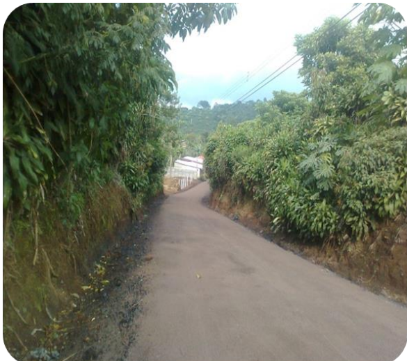
Tratamiento Superficial Bituminoso (TSB - 1) Calle Sibaja Costo: ₡ 7.482.200
