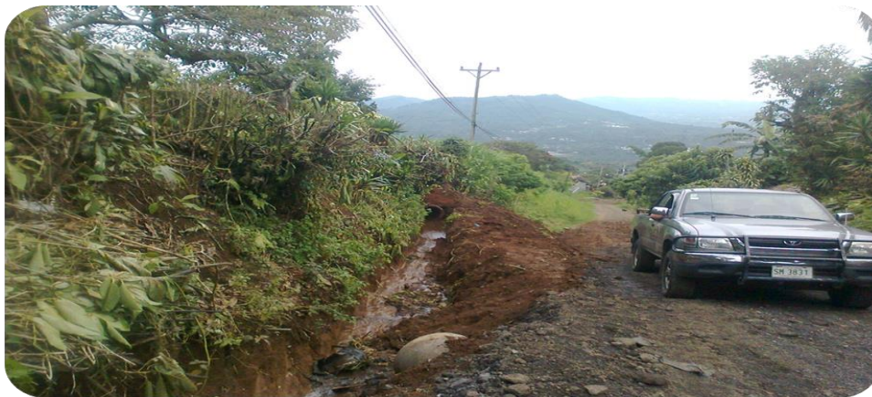
San Juan Calle Porosal Limpieza de entradas desfogue de Agua.
