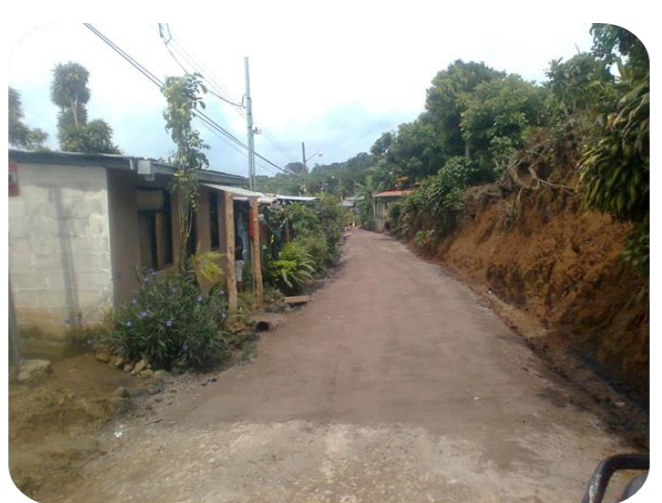
Tratamiento Superficial Bituminoso (TSB - 1) Calle Sibaja Costo: ₡ 7.482.200
