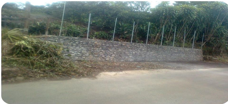
Dulce Nombre Calle Zapote, Construcción de Muro Costo: ₡1.200.025.00
