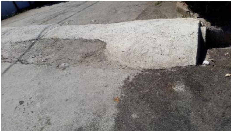
Acceso corregido por rampa -100 Este de capilla Barrio el Carmen
