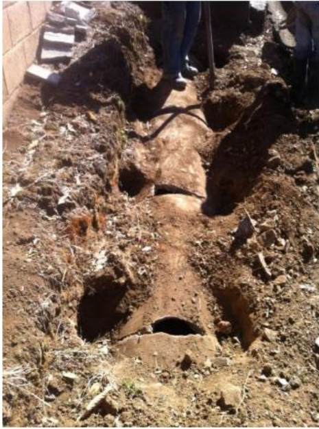
Sistema de alcantarillado colapsado en Barrio Corazón de Jesús-Cambio de alcantarillado colapsado- sector Rinaloza (inicio de la obra)
