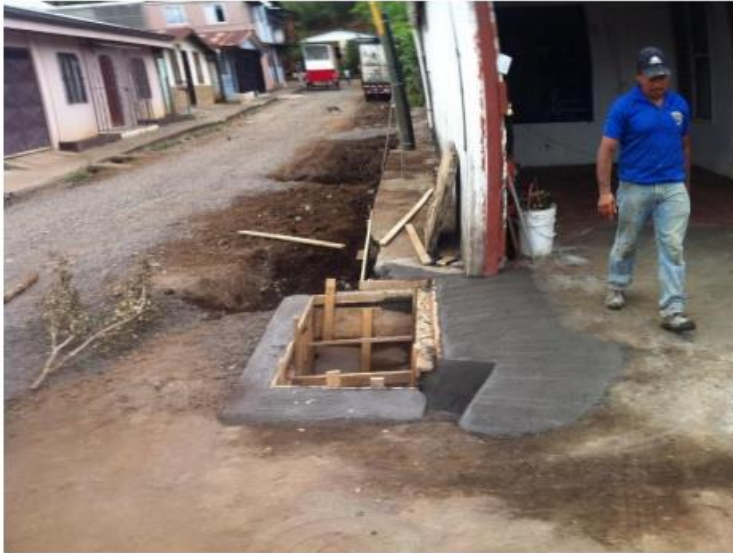
El IMAS Segunda entrada -Caja de Registro Terminada
