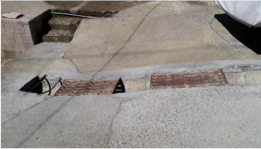
Obra de cuneteado, alcantarillado, construcción de rampas -100 Sur capilla Barrio el Carmen
