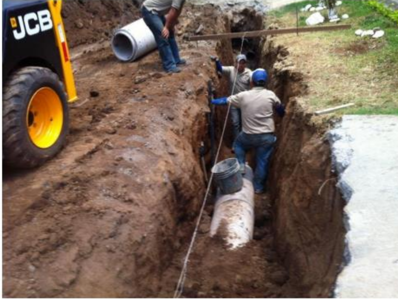
Barrió el Carmen – urbanización Coopenaranjo (ejecutando el proyecto)
