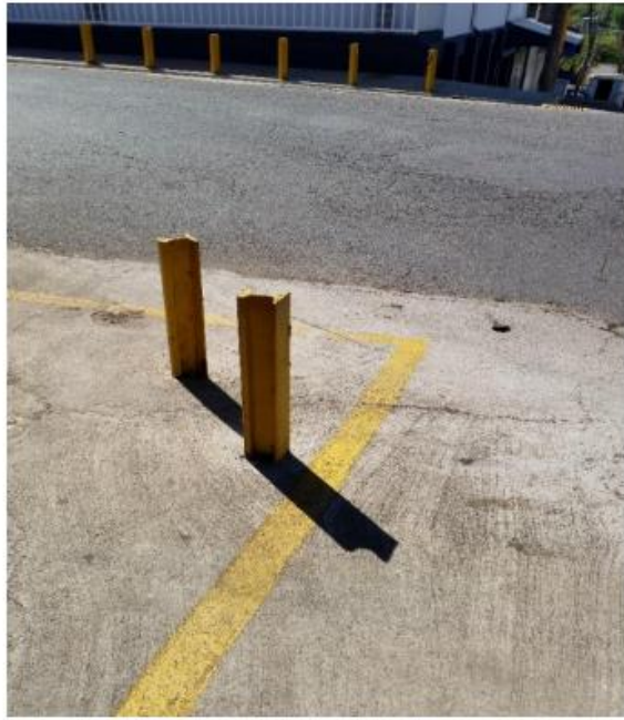
Rampa frente al ICE-trabajo en la caja de registro
