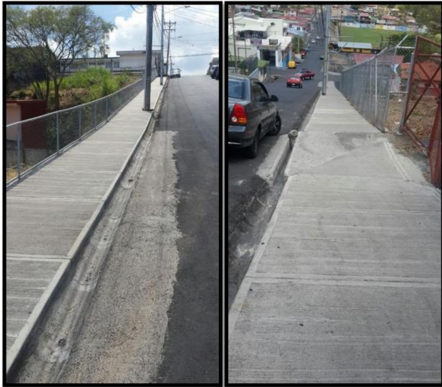
Construcción de aceras en sector CEN CINAI Barrio El Carmen en Convenio con los dueños de la propiedad
