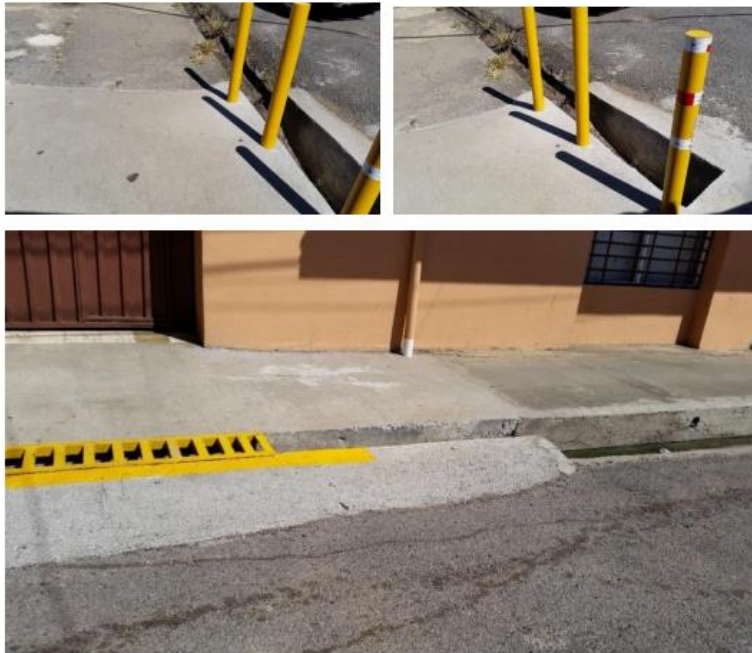
Ciudadela Marín –corrección del nivel de caño dando mayor pendiente –arreglo de acera con materiales de vecinos e instalación de rejas por los vecinos
