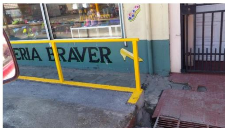
Construcción de rampa de acceso –zapatería. Braver –postes de protección comprados por el interesado.
