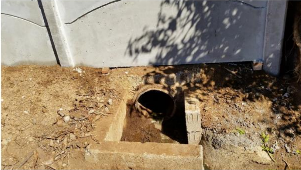
Obra terminada con desfogue a la calle pública –altura final SNS-3mts
