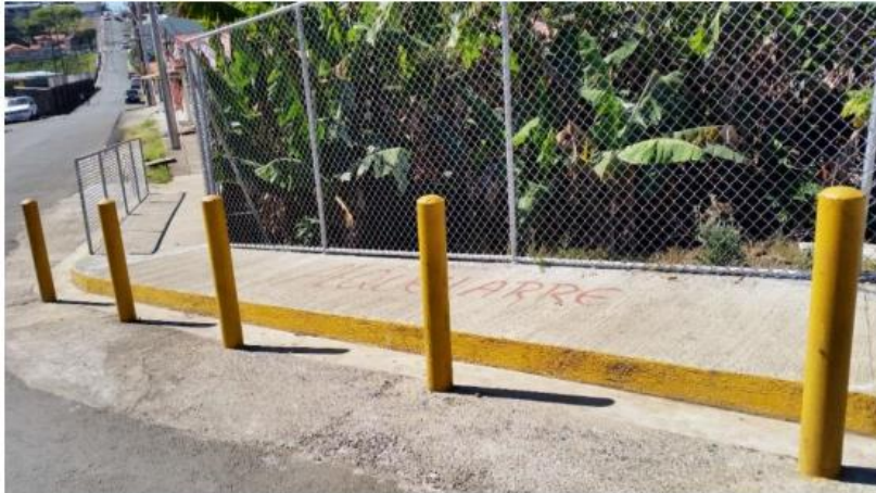
Construcción de acera –rampa peatonal, con protección para peatones, entrada principal al IMAS (trabajo terminado).
