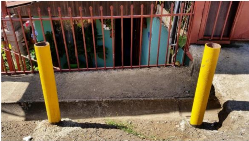
Postes de protección –calle Linda Vista-en calle de Salida –frente al Señor Ademar Alvarado
