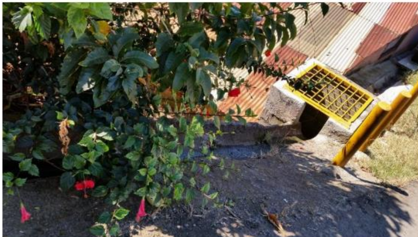
Cuneteado –construcción de caja de registro postes de protección en Linda Vista
