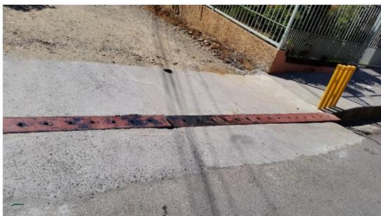
Ciudadela Marín –Construcción de caño chorreado, antes estaba en suelo, con rampa de acceso y platina financiada por los vecinos.
