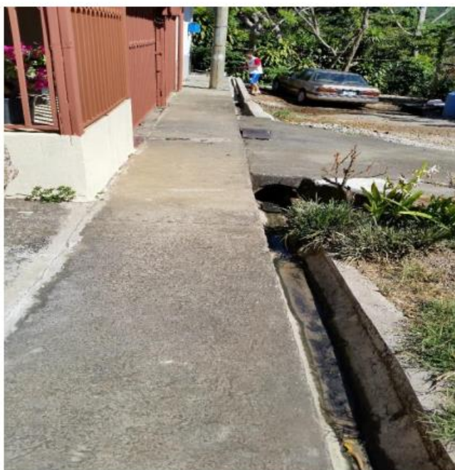
Urbanización Coopenaranjo –elevación del nivel de cuneteado (-Ejecutando)
